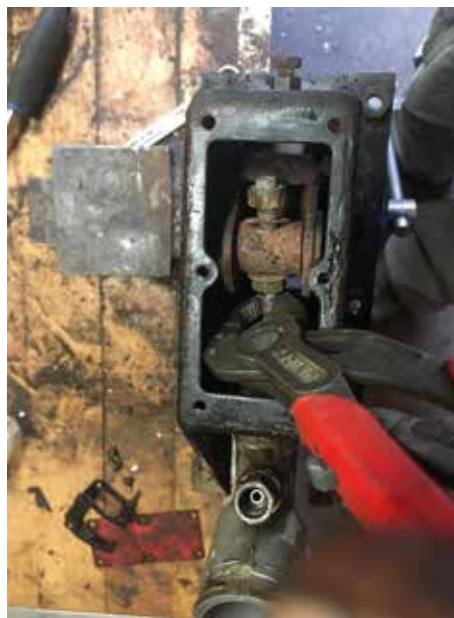
ØVERST TIL VENSTRE Powertool in action. Konsolboltene i fodbrønd løsnes.
